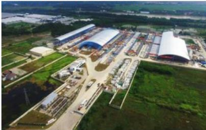
Gambar 1. Fasilitas Produksi Precast
